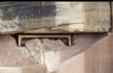
Eine Eisenklammer verbindet zwei Steine
