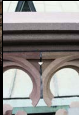
Bleifuge zwischen zwei Maßwerkelementen
