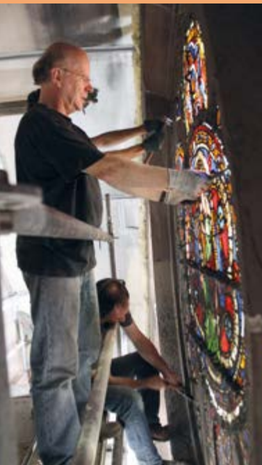
Ausbau der Glasscheiben im südlichen Seitenschiff
