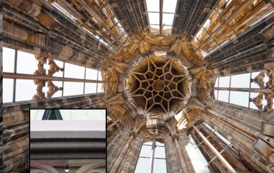
Der Achteckturm wird von Eisenbändern zusammengehalten
